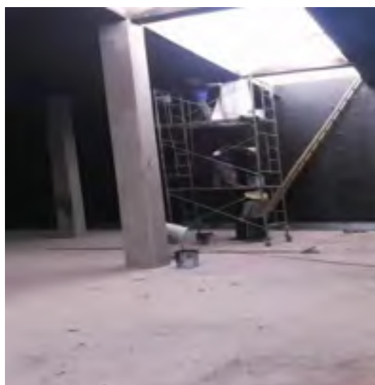
初期雨水池防渗施工
