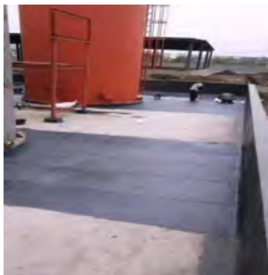
罐区防渗施工
