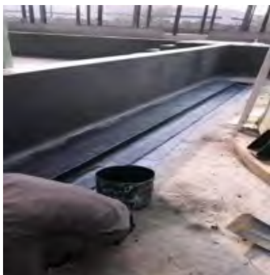
围堰四周防渗施工
