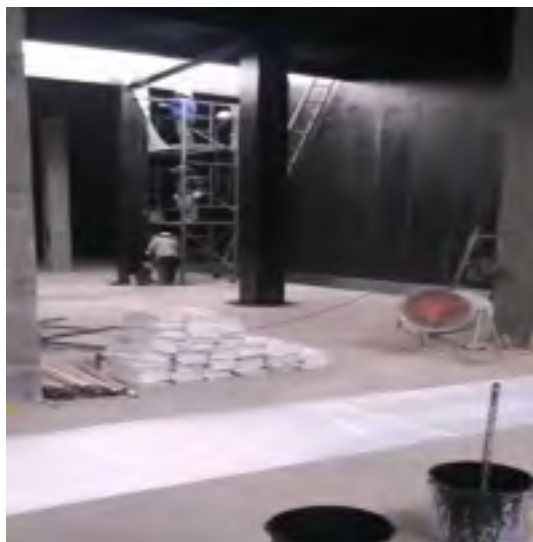
事故池防渗施工
